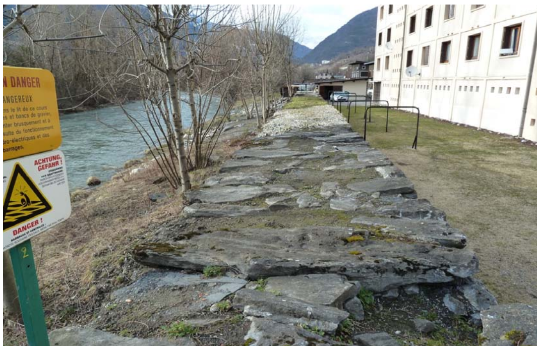
Figure 11 : Photo de la digue rive droite à Aigueblanche
